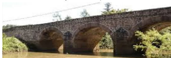
Figura 4: Ponte do Imperador
